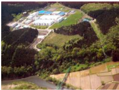
写真 2-8 ふもとやま 籠山浄水場
