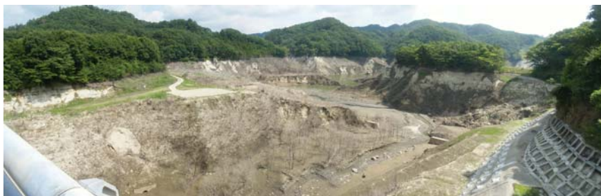
写真 2-19 干上がった「二ツ石ダム貯水池」
