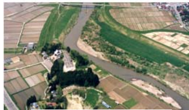
中流域の状況(39km 付近)
