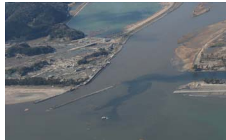
被災後河口部付近の状況
