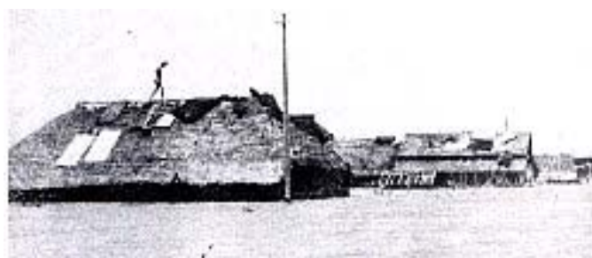
写真 2-4 昭和23年9月洪水 吉田川 旧鹿島台町(大崎市) にて堤防決壊と品井沼の溢水で浸水
