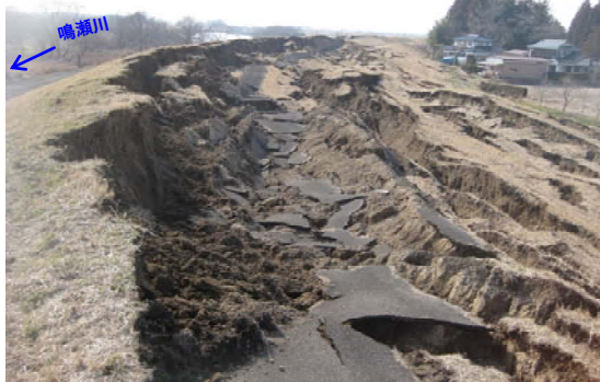
写真 2-25 鳴瀬川左岸 30.3k 付近
